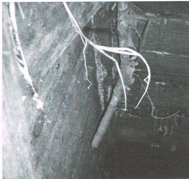
Rys. 5. Wnętrze kopanki ujawnia dobrze zachowaną drewnianą cembrowinę a na jej dnie ropę; gm. Iwonicz-Zdrój, woj. podkarpackie
