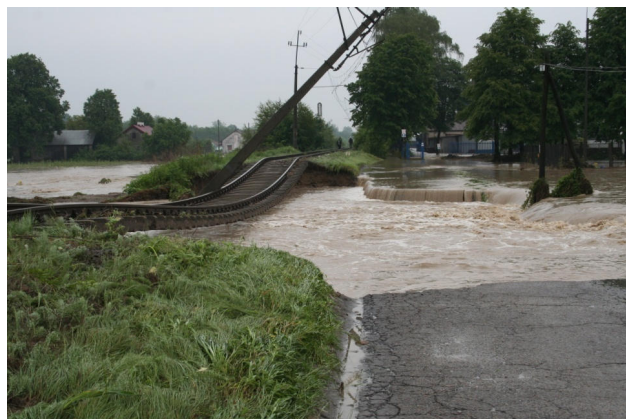
Fot. 2. Entropia malejąca (odpływające wody powodziowe i ukazujące się zniszczenia w powiecie jasielskim województwa podkarpackiego, czerwiec 2010) Źródło: Zbiory autora
