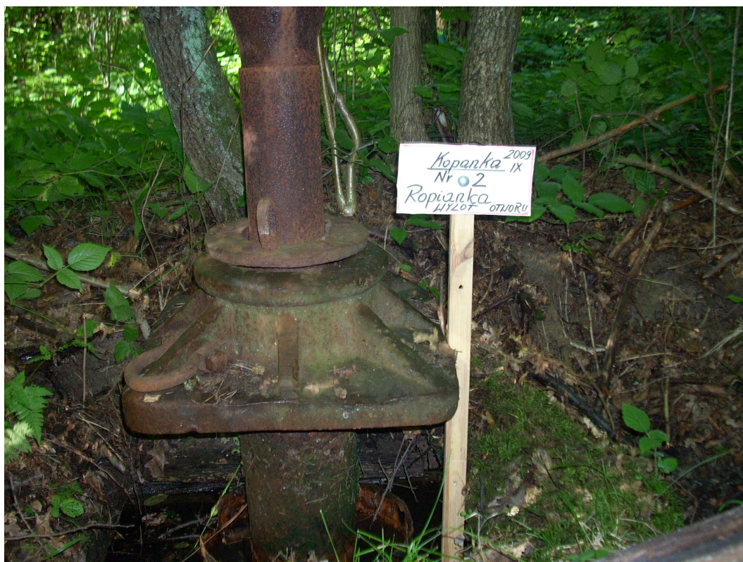
20. Ropianka – kopanka nr 3. Kopanka pogłębiona metodą wiertniczą z ujęciem ropnym.
