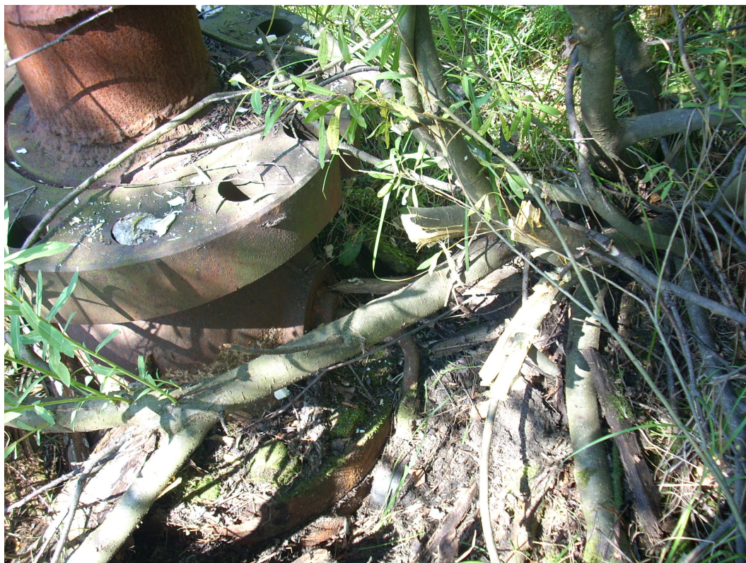
18. Ropianka – kopanka nr 1. Kopanka pogłębiona z widocznym zabezpieczeniem wylotu głowicą.
