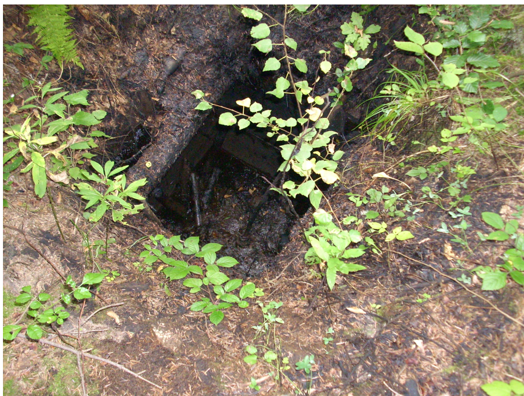
17. Wara – kopanka nr 3. Widoczny brak zabezpieczenia otworu.
