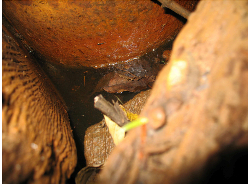
Ryc. 23. Stanowisko badań Nr 3. Kopanka z wodą i ropą ma zachowaną obudowę – cembrowinę – z drewna; widoczny jest fragment rury okładzinowej. Gm. Iwonicz-Zdrój, woj. podkarpackie, 2011.
