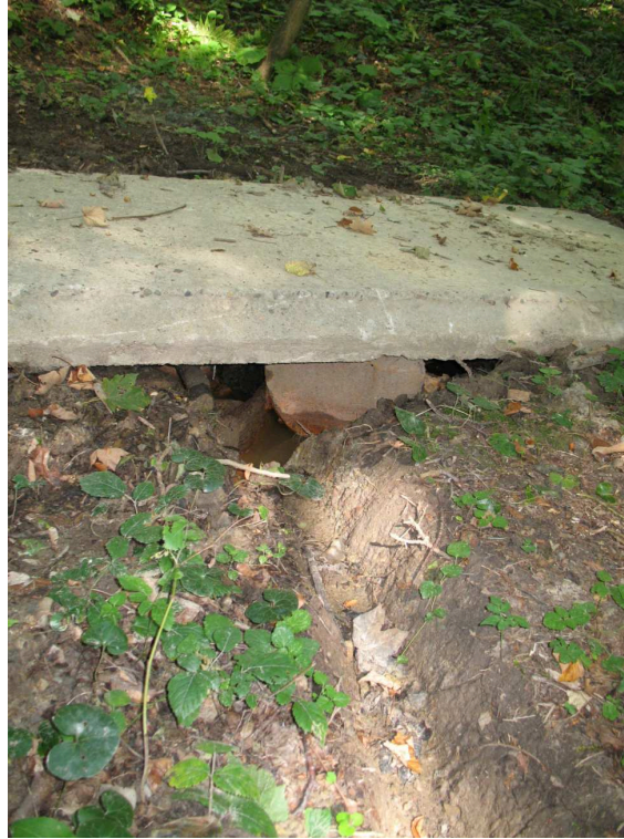
Ryc. 30. Stanowisko badań Nr 2. Kopanka z wodą zabezpieczona płytą betonową; koryto emisji ropy i wody. Gm. Iwonicz-Zdrój, woj. podkarpackie, 2011.
