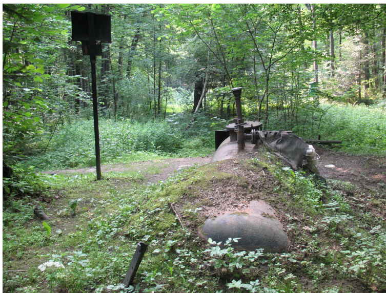
Ryc. 10. Zbiornik ropy naftowej; teren Zakładu Górniczego; strefa zagrożenia pożarowego i wybuchem. Gm. Iwonicz-Zdrój, woj. podkarpackie.
