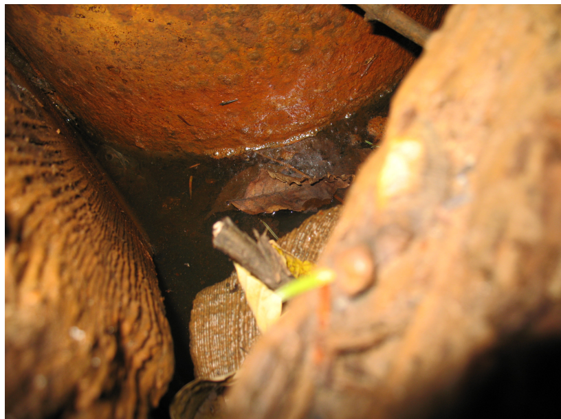
Rys. 3. Kopanka z zachowaną obudową z drewna – cembrowiną; widoczny jest fragment rury okładzinowej [13], zdjęcie E. J. Lipińska
