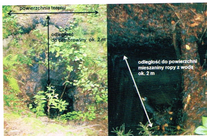
Ryc. 8.1.2. Studnia z XIX w. kopana ręcznie w poszukiwaniu ropy naftowej, Wara 2009 [34]
