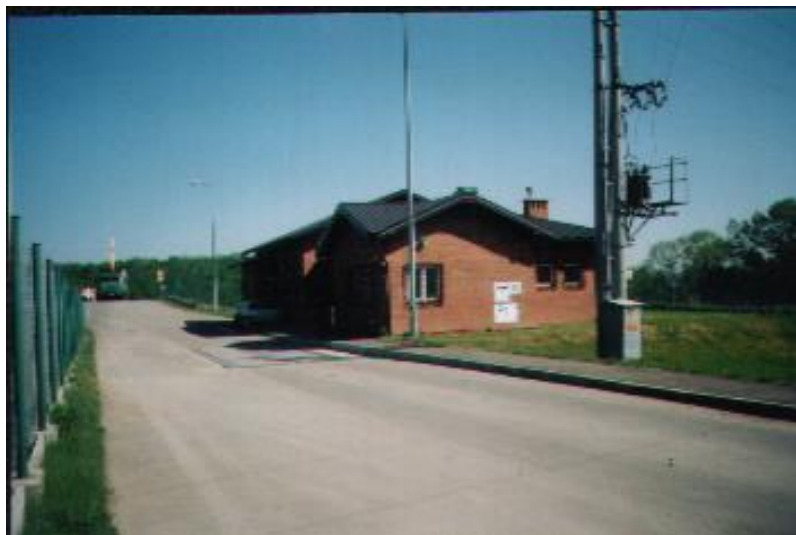
Zdjęcie 3. Budynek administracyjny (składowisko odpadów w Dukli)
