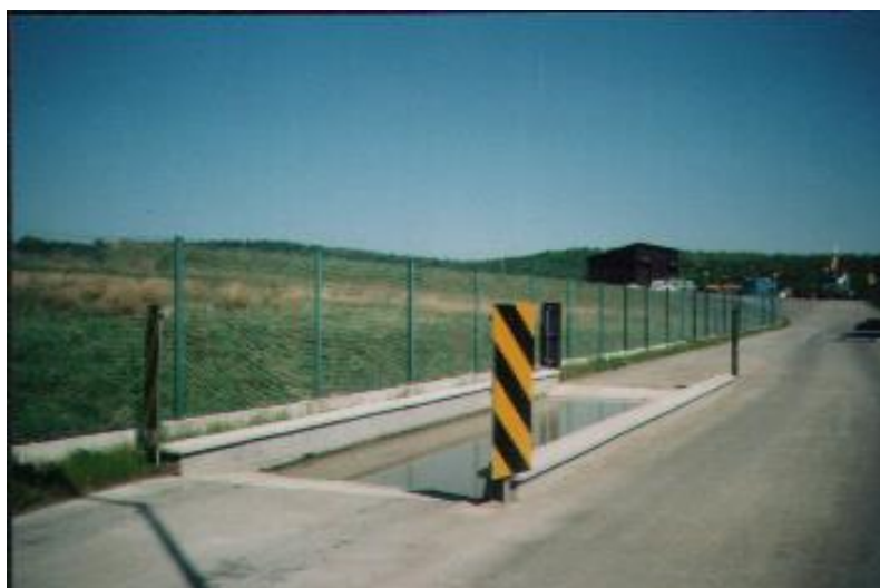
Zdjęcie 4. Stanowisko dezynfekcji kół samochodów opuszczających teren składowiska (składowisko odpadów w Dukli)
