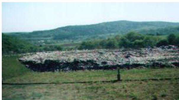
Zdjęcie 7. Kwaterna składowiska stopniowo wypełniana strumieniem odpadów (składowisko odpadów w Dukli)
