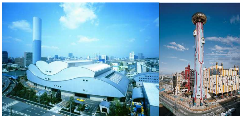
Rys. 8. Spalarnie stałych odpadów komunalnych w Tokio i Osace [6]
