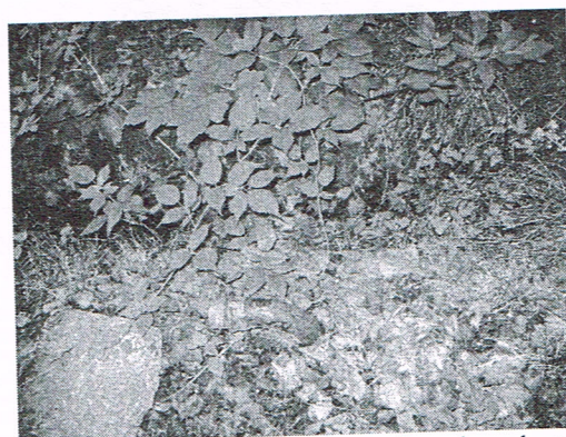
Rys. 13. Emisja i migracja przypowierzchniowa substancji węglowodorowych ze zbiornika ropy naftowej; elementy infrastruktury pozostawione w glebie; strefa zagrożenia pożarowego i wybuchem. Gm. Iwonicz-Zdrój 2012, woj. podkarpackie
