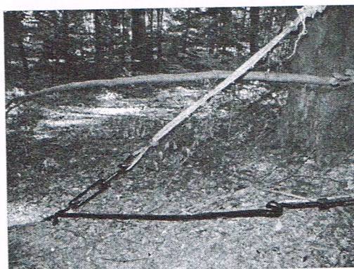
Rys. 16. Niezabezpieczony element stabilizujący kiwak . Gm. Iwonicz-Zdrój 2012, woj. podkarpackie
