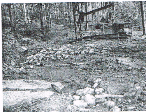
Rys. 14. Żuraw pompowy o napędzie indywidualnym zwany kiwakiem jest urządzeniem wprowadzającym w ruch przewód pompowy i pompę wglębną; teren Zakładu Górniczego; strefa zagrożenia pożarowego i wybuchem. Gm. Iwonicz-Zdrój 2012, woj. podkarpackie
